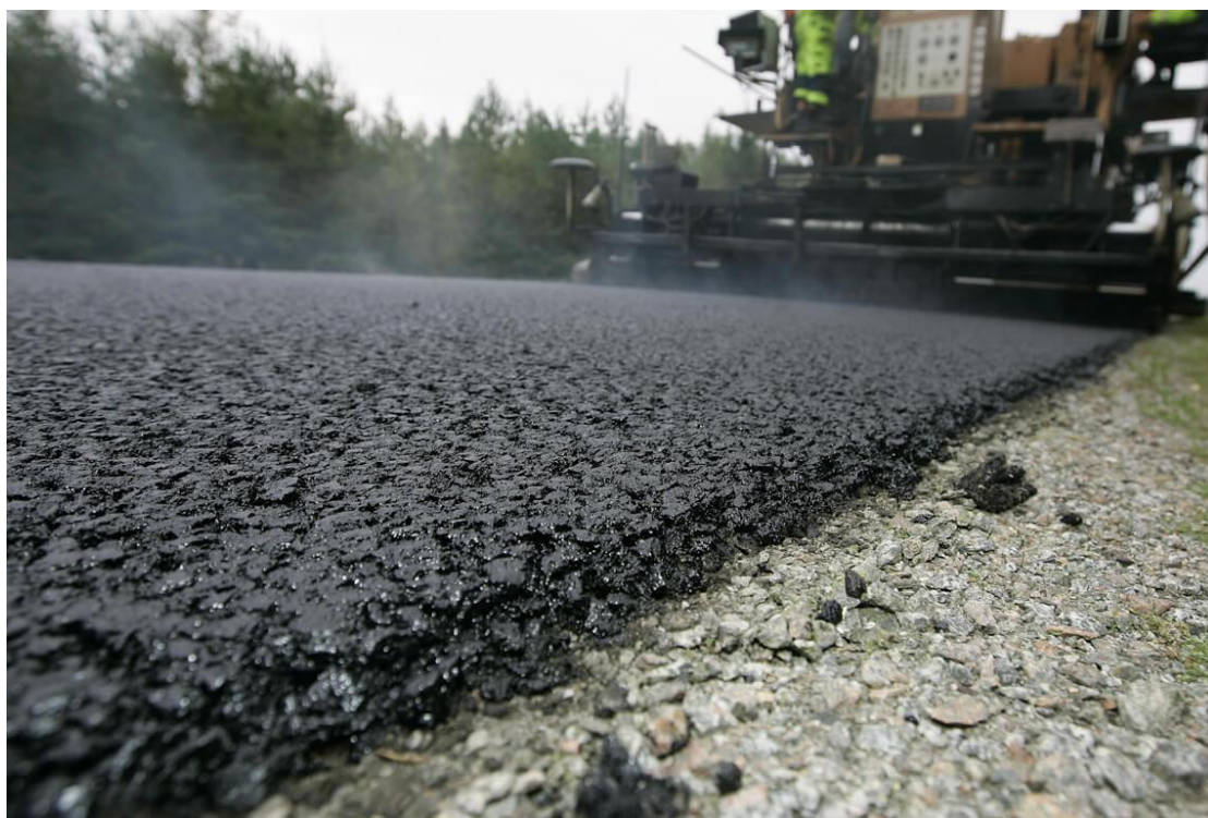
Рисунок 1 – Покрытие из асфальтобетона
