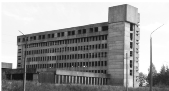
Рис. 7. Недостроенный административно-бытовой корпус в Сморгонском промузле
