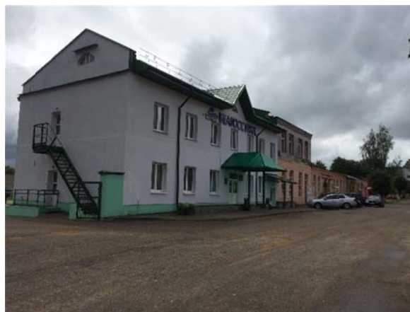
Рис. 3. Производственное здание в имении Святских, Крупки
