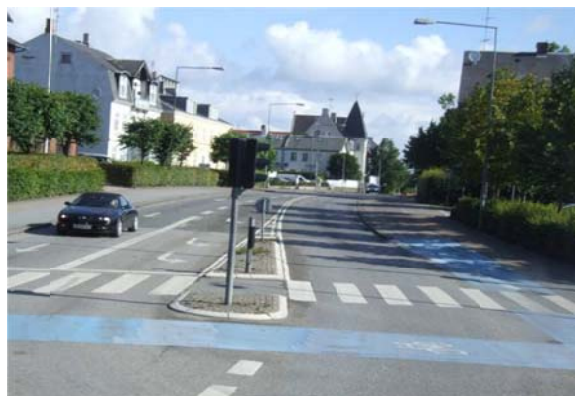
Рис. 4. Наземный регулируемый пешеходный переход с островком безопасности и выделенной полосой велодвижения в г. Торунь
