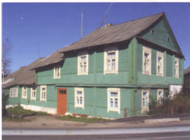
25 — Жилой дом в Ошмянах
