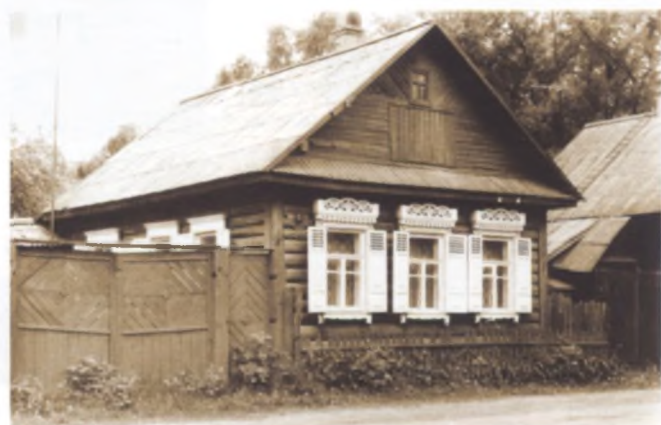
13 — Жилой дом в Рогачеве
