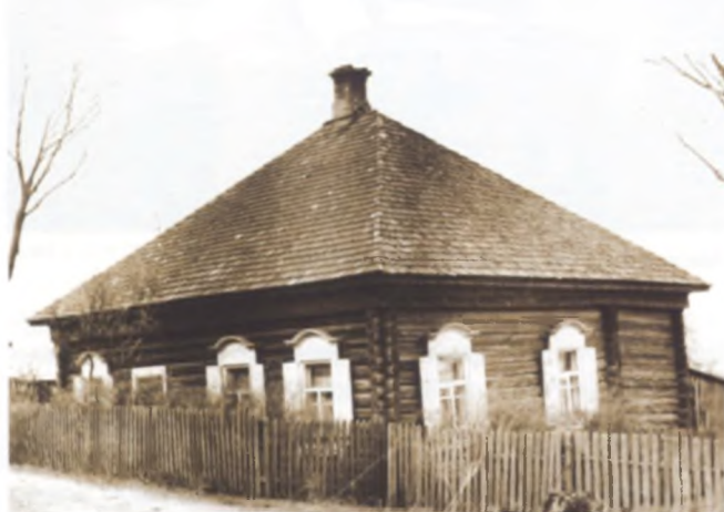
11 — Жилой дом в Городке Глусского района
