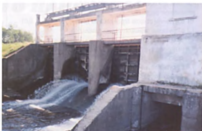
Рисунок 2 — Бетонная водосливная плотина
