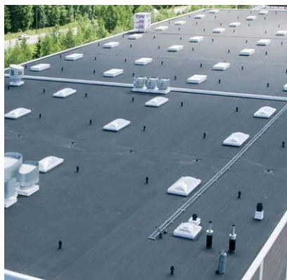
Рис. 5. Кровля с установленными флюгарками
