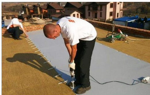
Рис. 4. Установка механического крепежа
