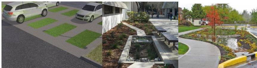
Рис. 3. Элементы «сине-зеленой» инфраструктуры (водопроницаемое покрытие, дождевой плантатор, дождевой сад соответственно) [6]
