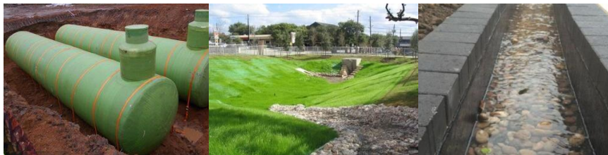
Рис. 2. Элементы «синей» инфраструктуры (подземные накопители, «сухой» пруд и водоотводный канал соответственно) [6]
