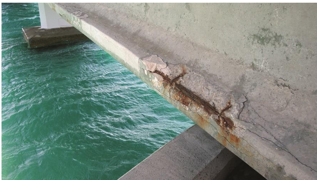
Рисунок 1 – Коррозия бетона
