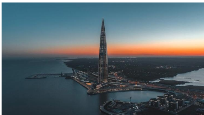
Рисунок 1 - «Лахта Центр», Санкт-Петербург.
