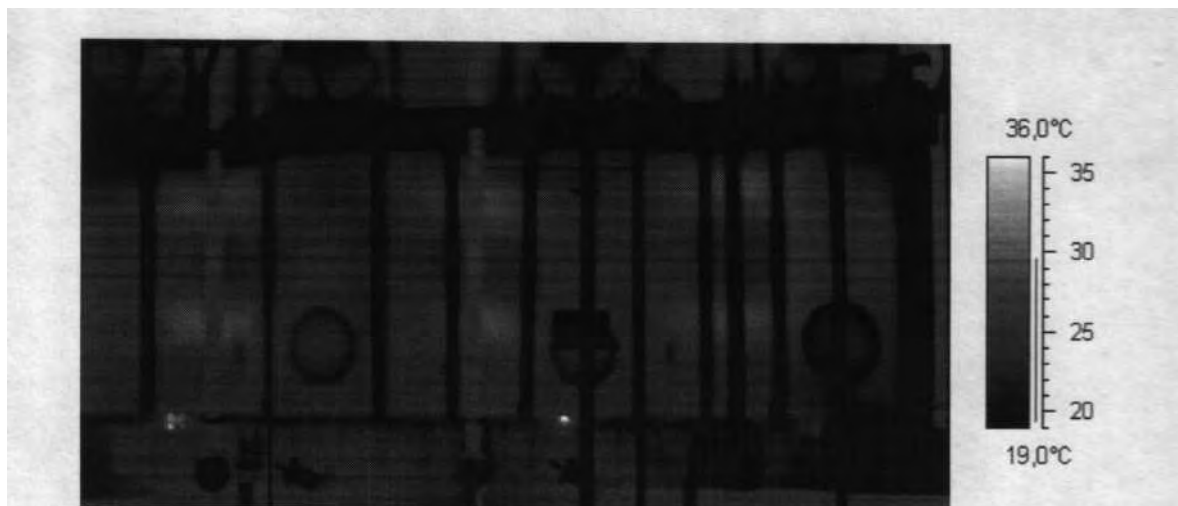
Рисунок 39 - Термограмма поверхности бака трансформатора типа ТДЦГ-250000/220 со стороны вводов ВН
