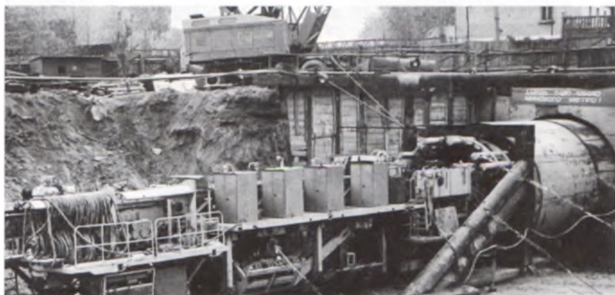
Фото 3 — Механизированный щитовой комплекс КТ – 5.6-Д 2
