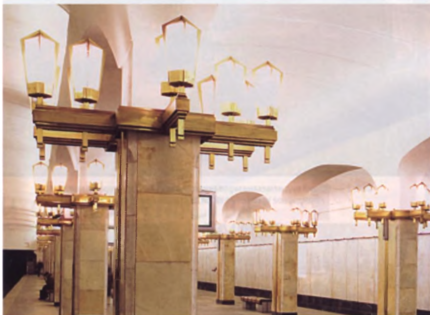
Фото 6 — Станция «Пушкинская». Конструкция станции представляет собой трехпролетное подземное сооружение со сводчатыми перекрытием, выполненным в сборно-моноклитном варианте
