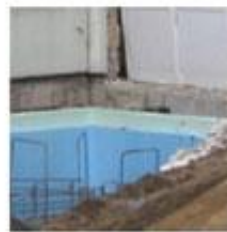
Изоляция пола атриума
