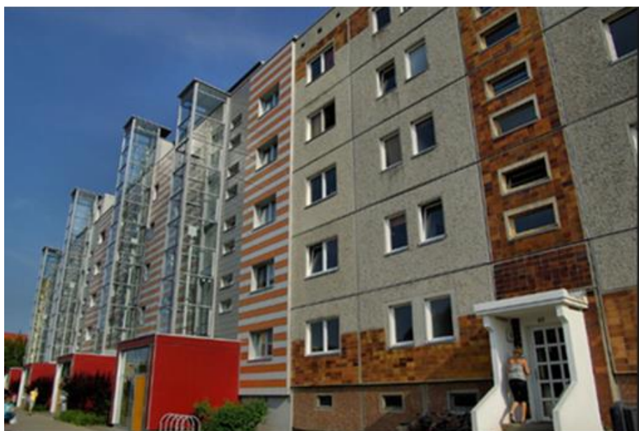
Рис. 2.26. Устройство входов в пристроенные лифты. Общий вид здания до и после пристройки лифтов и вестибюлей
