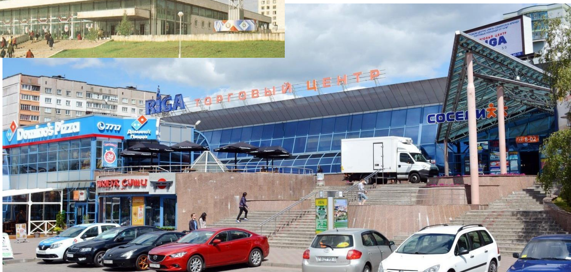
Рис.3.1. Реконструкция торговых центров «ЦУМ» и «Рига» в Минске
