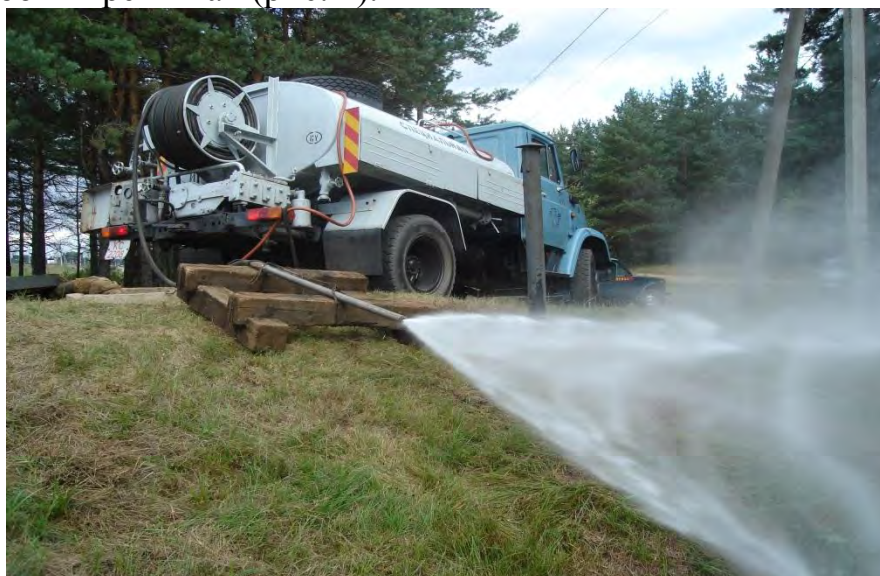
Рис. 2. Проверка работы генератора ГД2В-3В перед спуском в скважину № 25, водозабор «Дражня»
