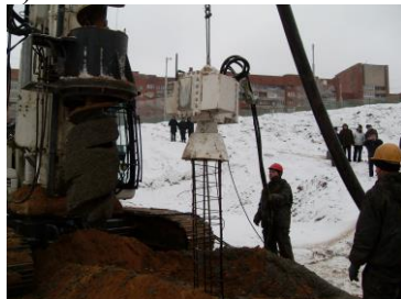
Рис. 2. Оборудование для устройства свай SFA: а – буровой станок со сплошным полым шнеком; б – буровой станок для проходки скважин; в – подъем шнека с бетоном на лопастях и погружение вибратором арматурного каркаса в скважину
