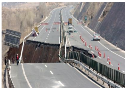
Рис. 3. Провал при оползне на скоростной дороге в Северном Китае (28 марта 2010 г.) возник кратер 10 м при ширине и глубине по 10 м
