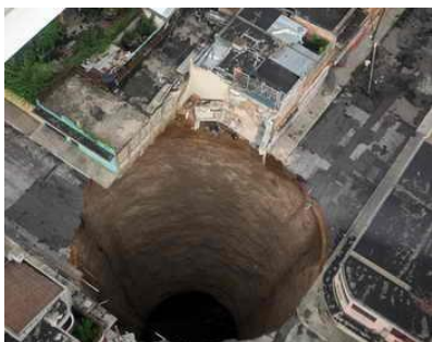
Рис. 1. В Нижнем Новгороде 10 апреля 2013 г. за счет просадки грунта образовалась воронка Ø 85 м, под землю сползли 3 дома
