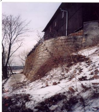
Рис. 2. Общий вид Каложской церкви (а) и укрепленной анкерами подпорной стены возле нее (б)
