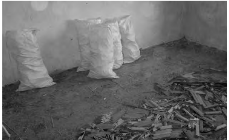
Рис. 2. Отходы после демонтажа пола
