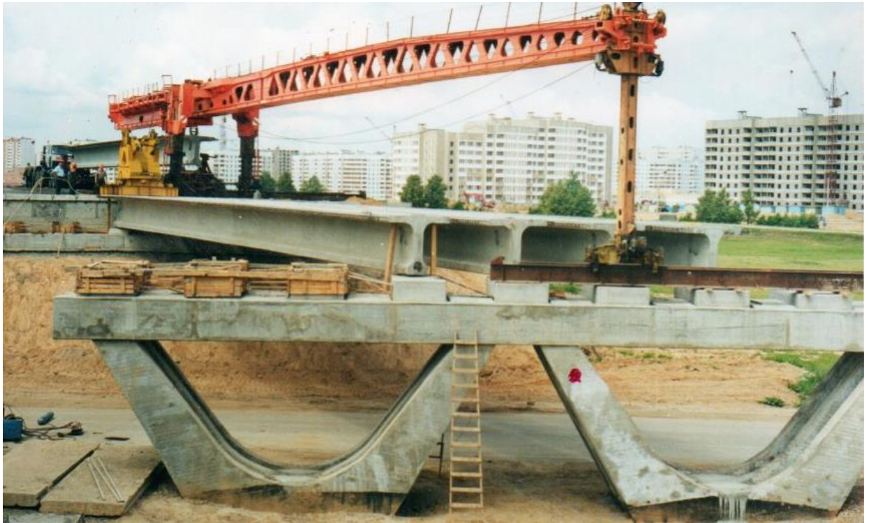
Рис. 10.1.9. Монтаж балок пролетного строения на рамную опору.
