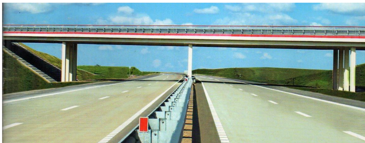
Рис. 10.1.8. Четырехпролетный балочный путепровод на М–14.
