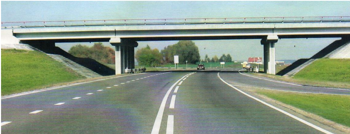
Рис. 10.1.7. Трехпролетный балочный путепровод.
