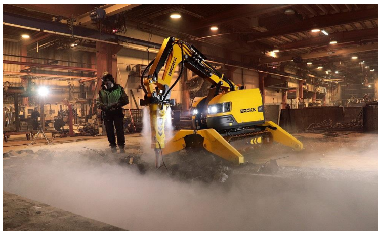
Рисунок 4 – Робот с системой пылеподавления Brokk
