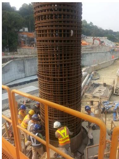
Рисунок 2 – Установление каркаса
