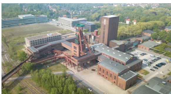
Рис. 3. Шахта Цольферайн в г. Эссен, Германия
