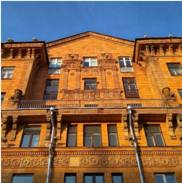
Рис. 4. Керамические блоки на фасаде здания по пр. Независимости в Минске
