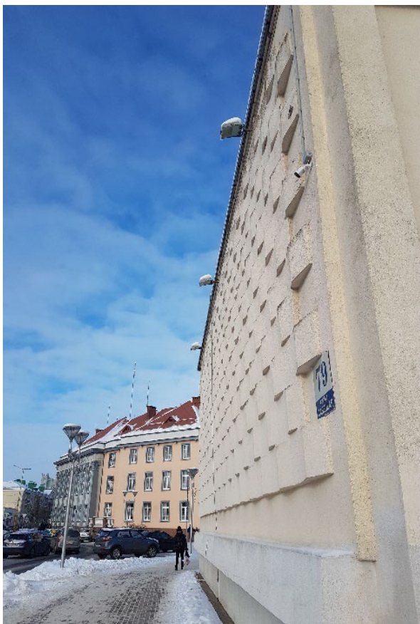
Рис. 12. Барановичский райисполком. Объемные стеновые элементы одноэтажной пристройки
