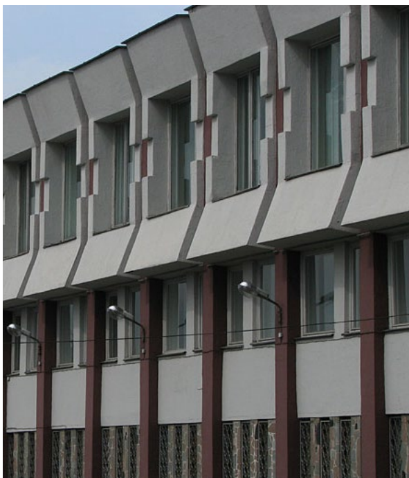
Рис. 6. Фрагмент фасада НИИ ЭВМ в Минске
