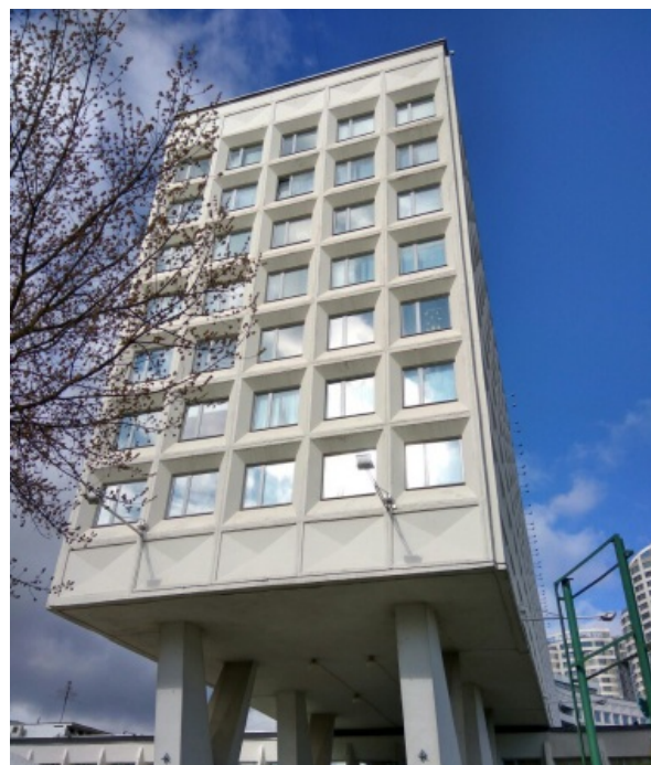
Рис. 9. Торец здания института Белгоспроект
