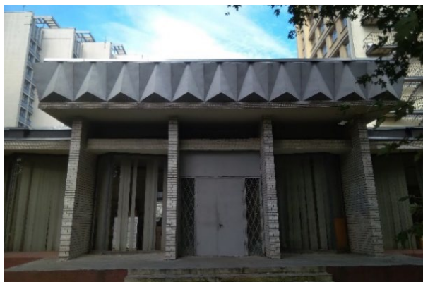
Рис. 17. – Козырек входа со складками
