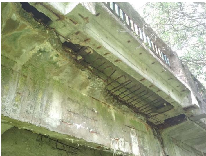
Рис. 1.3. Разрушение балки пролетного строения
