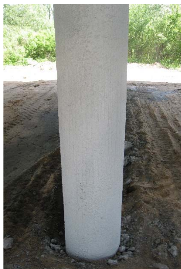
Рис. 5.4. Состояние защитного слоя через 14 и 27 месяцев
