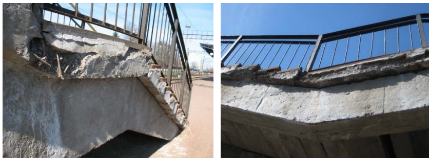
Рис. 5.1. Разрушение защитного слоя железобетонных лестниц
