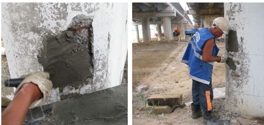
Рис. 5.2. Восстановление защитного слоя опоры ремонтными бетонными смесями с добавкой отработанной глины
