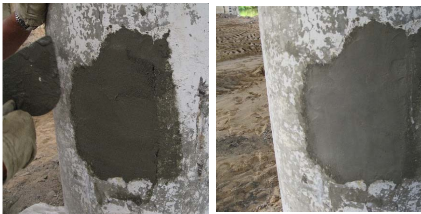
Рис. 5.3. Защитный слой непосредственно после нанесения ремонтной бетонной смеси и через 90 суток
