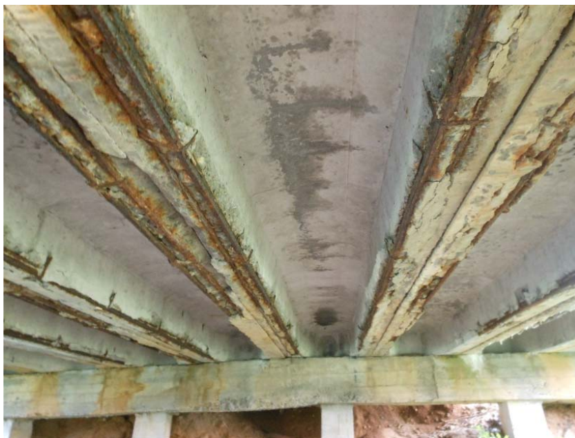
Рис. 1.4. Разрушение плитно-ребристого пролетного строения
