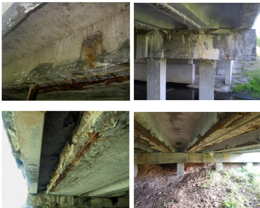
Рис. 1.1. Разрушение защитного слоя и коррозия арматуры
