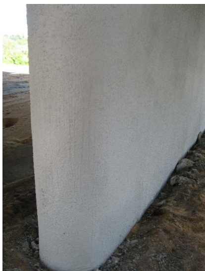
Рис. 5.4. Состояние защитного слоя через 14 и 27 месяцев
