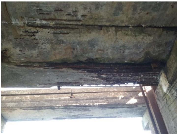
Рис. 1.2. Разрушение плитного пролетного строения
