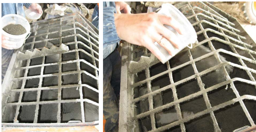
Рис. 5.5. Введение добавки ОГ в смесь для торкретирования пролетных строений
