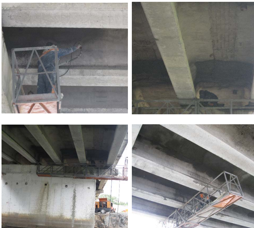
Рис. 5.7. Нанесение ремонтной бетонной смеси с добавкой ОГ на балки пролетного строения методом торкретирования
