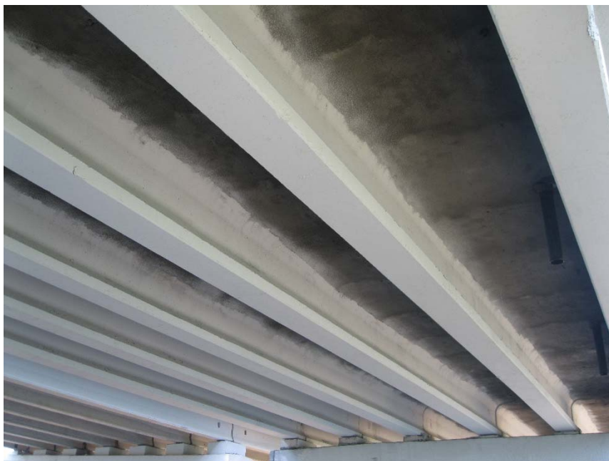
Рис. 5.8. Состояние поверхности торкрет-бетонного слоя через 27 месяцев после нанесения
