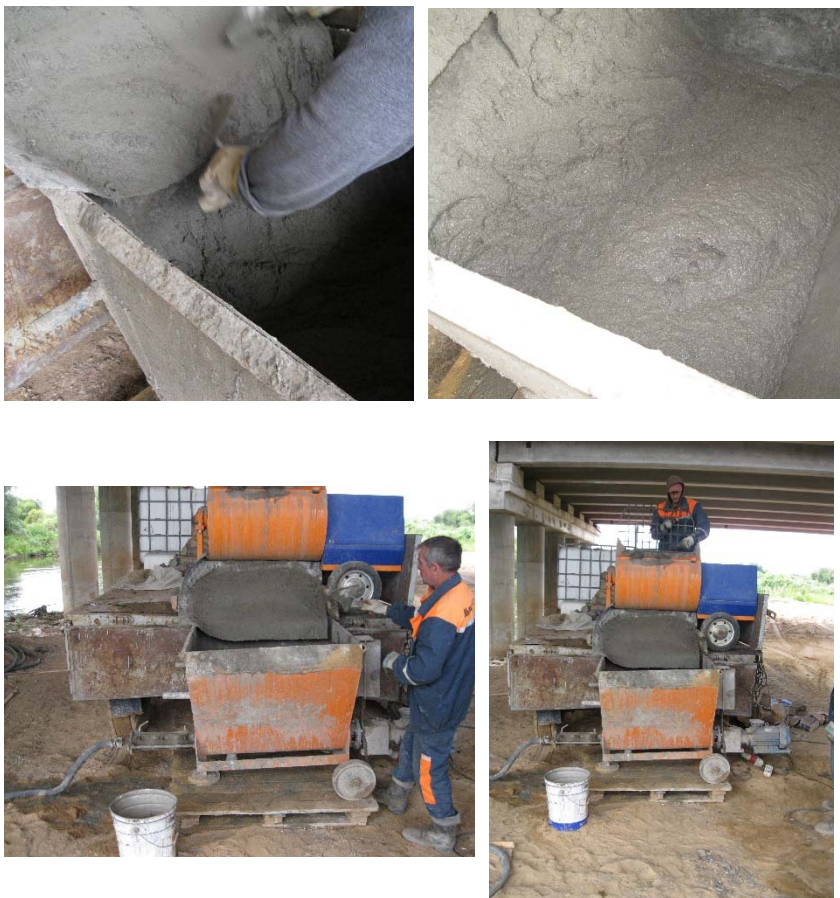
Рис. 5.6. Приготовление и подача ремонтной бетонной смеси к месту торкретирования
