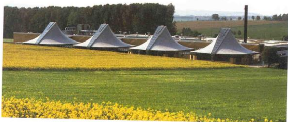
Рис. 4. 92. Одноэтажные склады мебельной Фабрики в Бад-Мюндер, Германия, инженер Отто Фрэй
