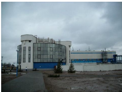
Рис. 4. 76. Корпус обслуживания рабочих на заводе по производству газетной бумаги в Шклове, Беларусь
