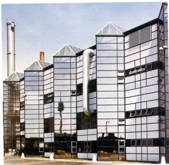
Рис. 4. 58. Литейный корпус металлургического завода в Нюрнберге, Германия, арх. Э. Фар и Д. Шарх
