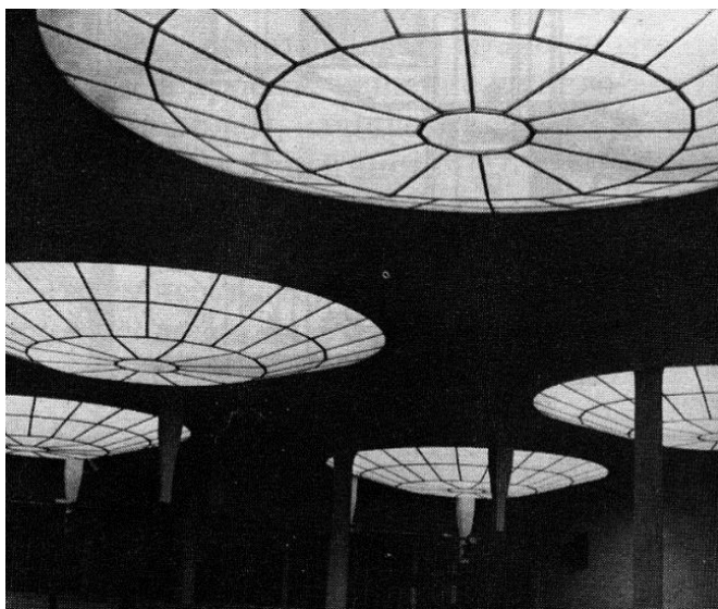
Рис. 2. 17. Богодуховская мануфактура братьев Морозовых, Россия. Зенитные фонари покрытия.
