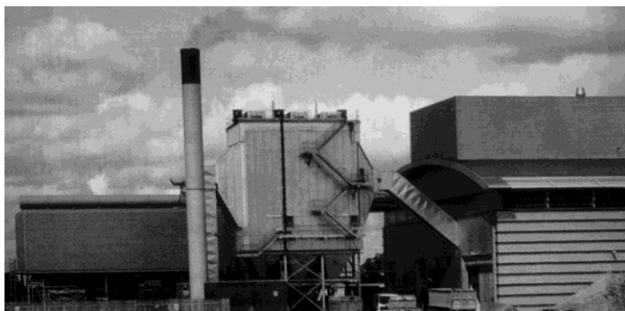
Рис. 2.18. Электростанция на биотопливе в Суффолке, архитектор Л. Давидсон, Великобритания
