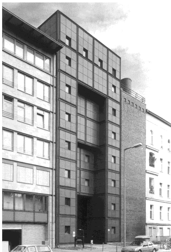
Рис. 2. 19. Трансформаторная станция в Берлине, Германия, архитекторы М. Дюдлер и К. Дюдлер
