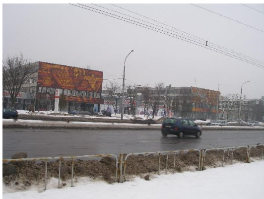
Рис. 4. 82. Административно-бытовые блоки электролампового и электромеханического заводов Брестского Восточного промышленного узла, Беларусь
