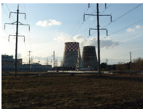
Рис. 4. 72. Башенные градирни на супер-Фосфатном заводе в Гомеле, Беларусь
