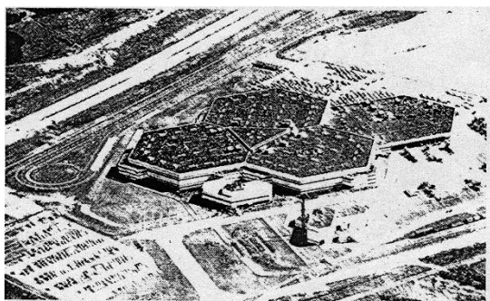
Рис. 4. 17. Сборочный корпус автомобильного завода Вольво в Кальмаре, Швеция
