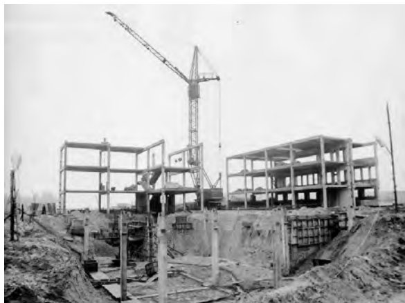
Рис. 4 Строительство промузла в г.Сморгонь
