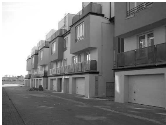
Ryc. 3. Osiedle „Zielone ogrody” w Lesznowoli. Nadmierne utwardzenia i brak zieleni. Źródło: fot. Autorów
