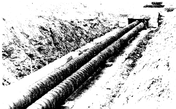
Рис. 2. Строительство СК трубопровода в Минске
