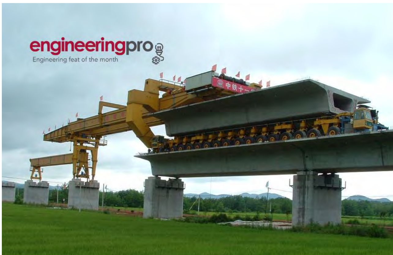
Рисунок 2 – Пример работы мостоукладчика SLJ900/32.
