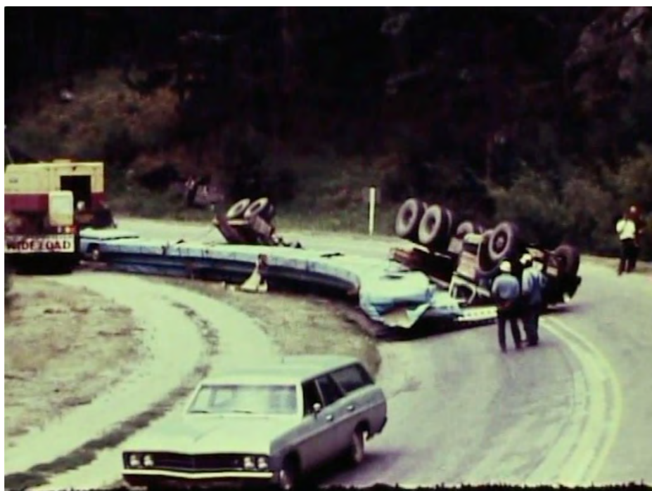
Рисунок 2 – Перевернутый грузовик во время строительства
