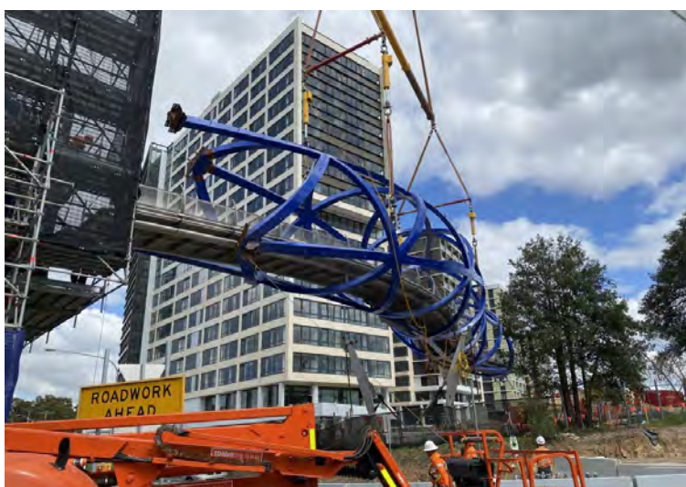
Рисунок 3 – Соединение секций
