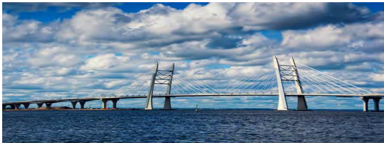
Рисунок 1 – Мост через Корабельный фарватер
