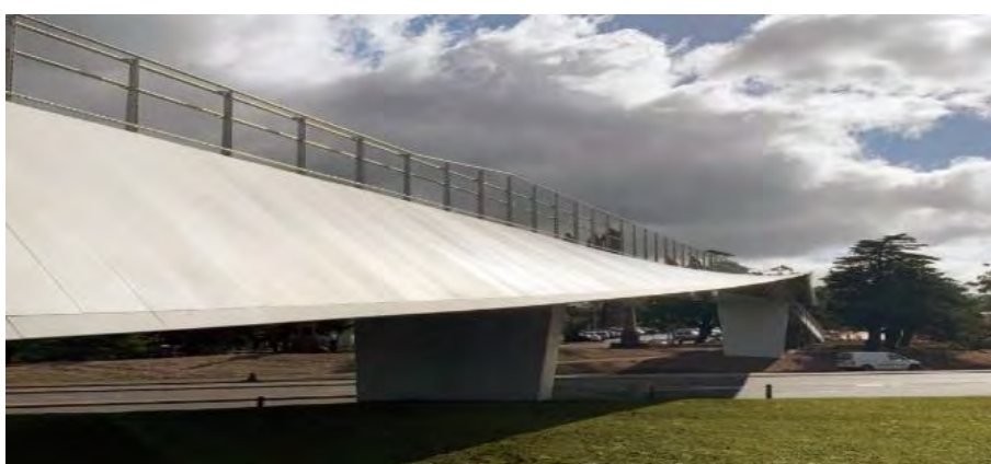
Рисунок 5 – Крылья моста опущены
