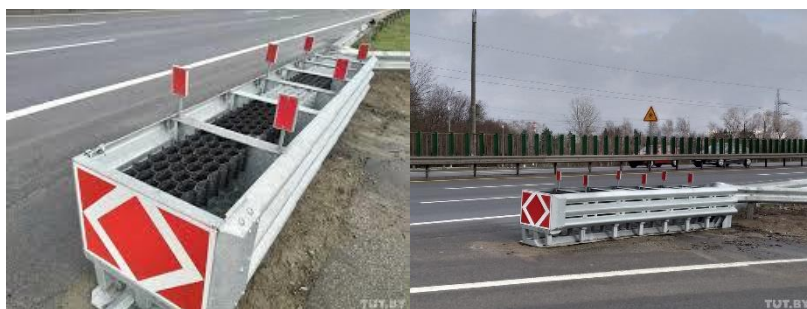
Рис. 4. Конструкция фронтального барьерного устройства (производство г. Санкт-Петербург, РФ)
