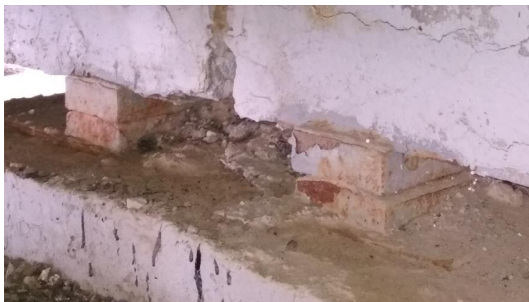
Рис. 1. Тангенциальные металлические опорные части в составе эксплуатируемого сооружения
