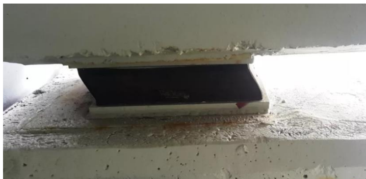
Рис. 2. Резинометаллическая опорная часть в составе эксплуатируемого сооружения
