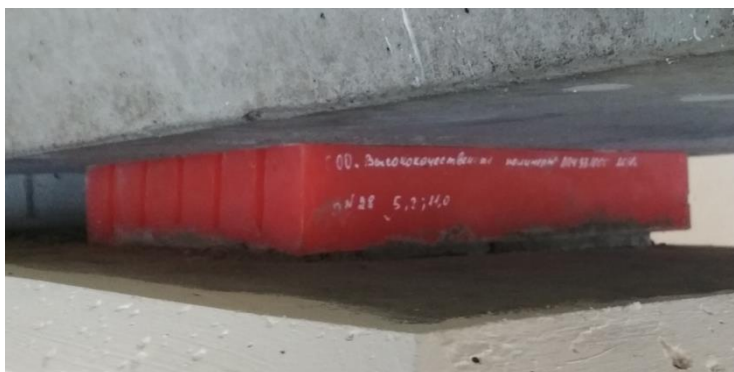
Рис. 3. Полиуретановая опорная часть в составе эксплуатируемого сооружения
