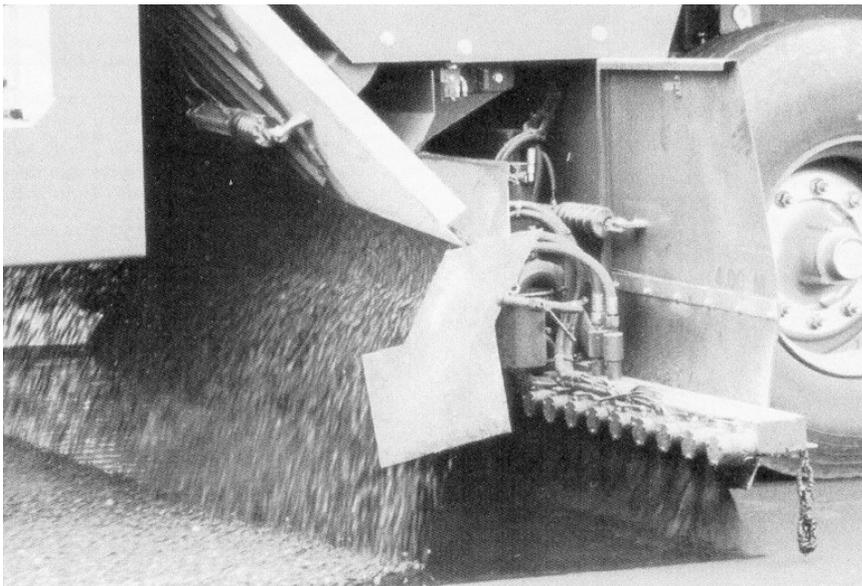
Рис. 4.77. Технологический процесс производства поверхностной обработки, выполняемый машиной типа «Чипсилер»
