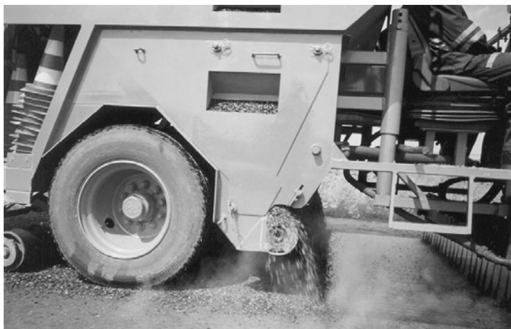
Рис. 4.82. Технологический процесс производства поверхностной обработки, выполняемый ремонтным поездом RZA-4000 фирмы «SCHAEFER»
