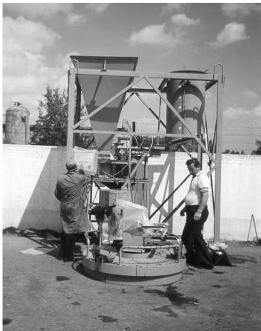
Рис. 4.37. Установка для приготовления, дозирования и затаривания эмульсионно-минеральных смесей производства СКТБ «Техноприбор» (г. Гомель)
