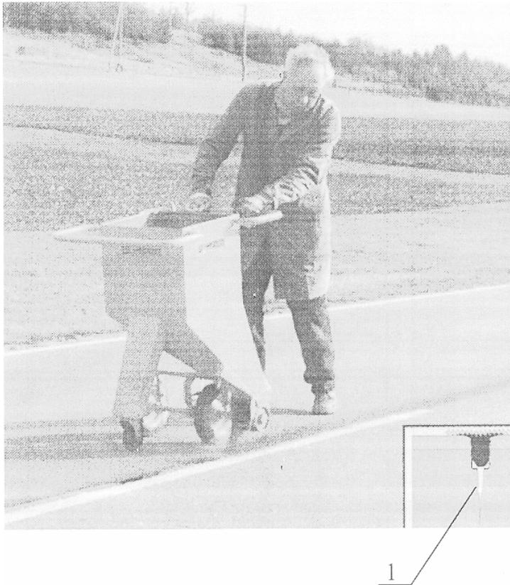
Рис. 4.66. Ручной щебнераспределитель:
