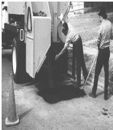
6. Смесь подается из бункера через установленный сзади машины поворотный лоток или на специальный помост
