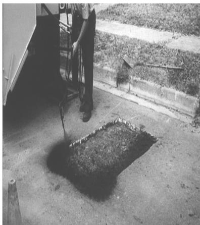
5. При помощи этого же пневматического устройства в выбоину равномерным слоем разливается подгрунтовка
