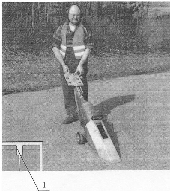
Рис. 4.63. Сопло для просушки и прогрева ремонтируемых трещин:
