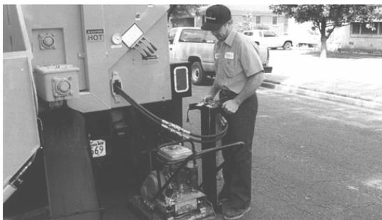
1. Чтобы уменьшить риск получения профессиональных травм, виброплита и гидравлический молоток расположены на опускаемой платформе
