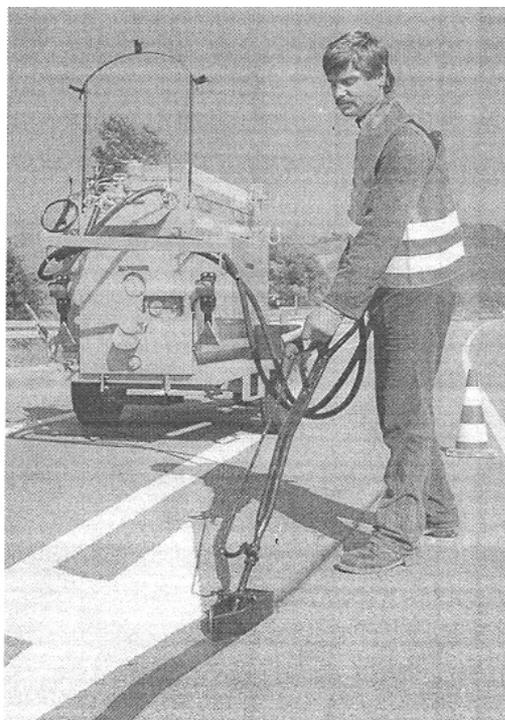
Рис. 4.65. Форсунка для заливки швов
