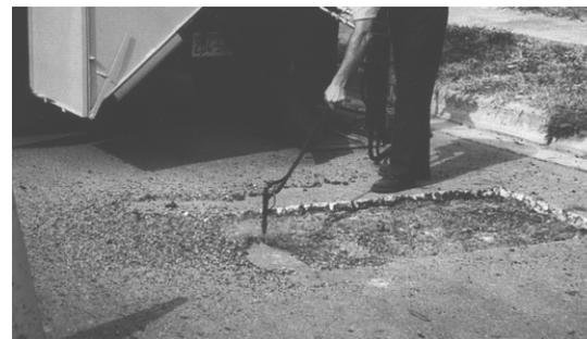
4. Подготовленная к ремонту карта продувается уникальным пневматическим устройством, являющимся частью установки TP-4
