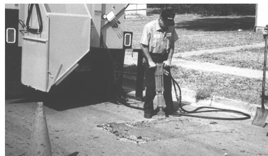
2. Гидравлический отбойный молоток равномерно вырезает вертикальные стенки для долговременной заплатки
