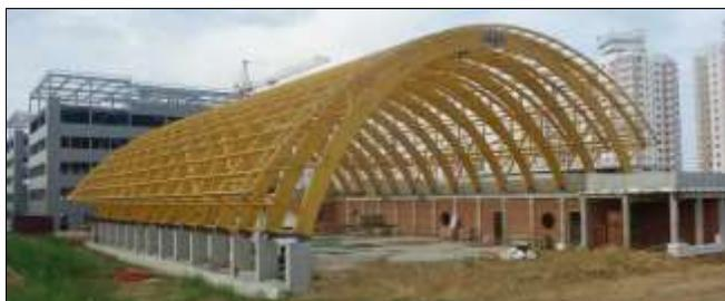
Рис. 8. Общий вид в стадии монтажа арочного покрытия физкультурно-оздоровительного центра Парка высоких технологий
