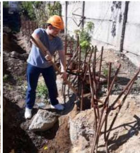
Рис. 3. Процесс очистки поверхности сваи
