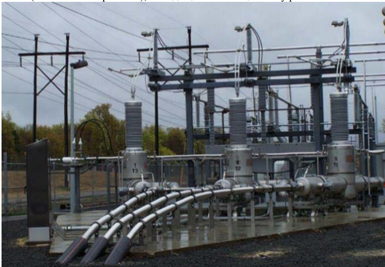
Рисунок 3 – Концевая муфта
