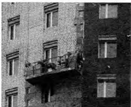
Рис. 8.8.1. б. Утепление зданий «легким мокрым» способом
