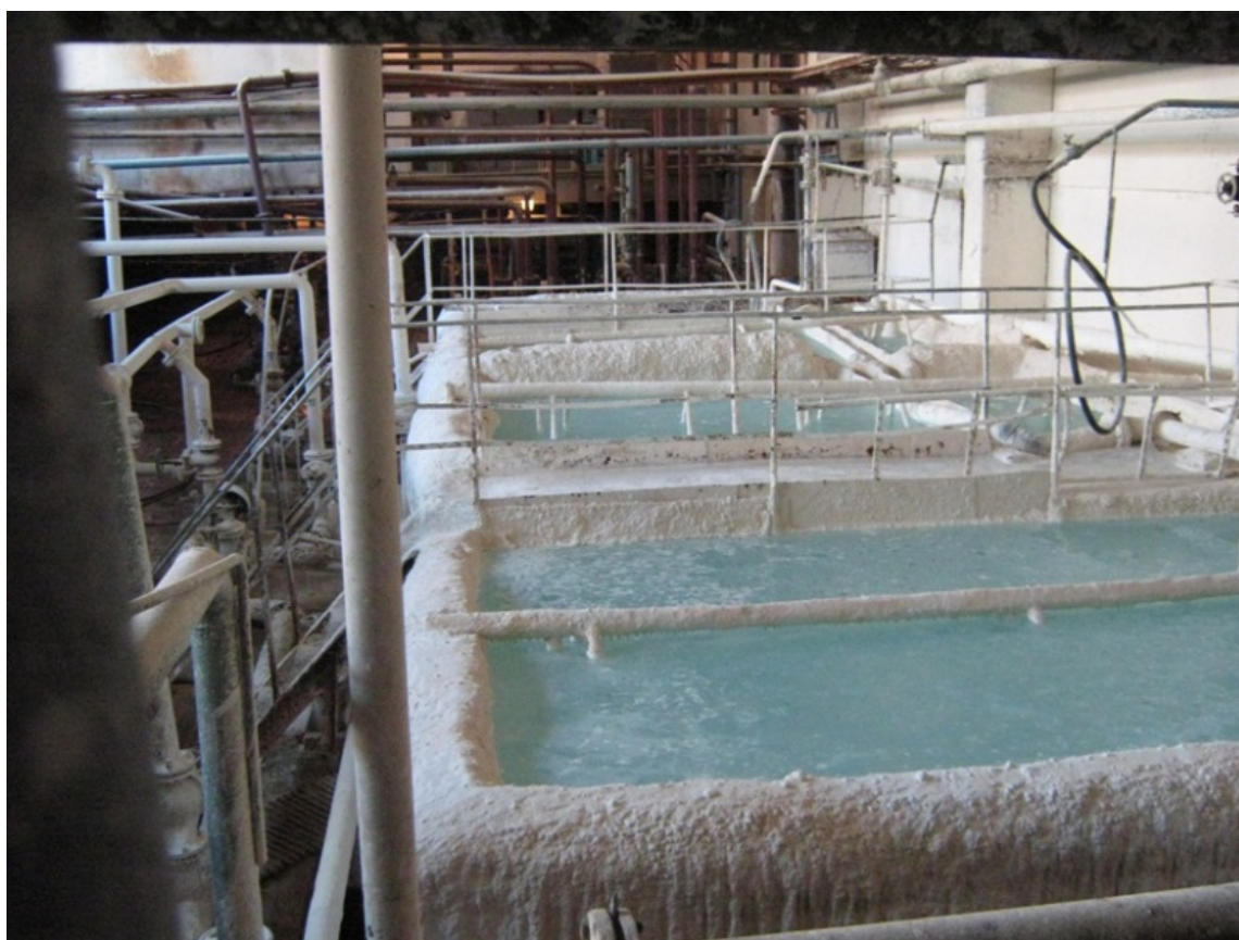
Рисунок 4 – Бассейн для приготовления гашеной извести
