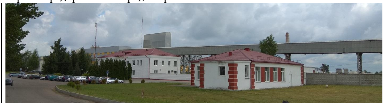
Рисунок 11. Панорамный вид предприятия со стороны автомобильной дороги (фото из личного архива)
