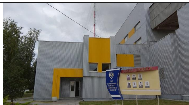
Рисунок 18. Элемент фасада. Обшивка профилированным листом (фото из личного архива)
