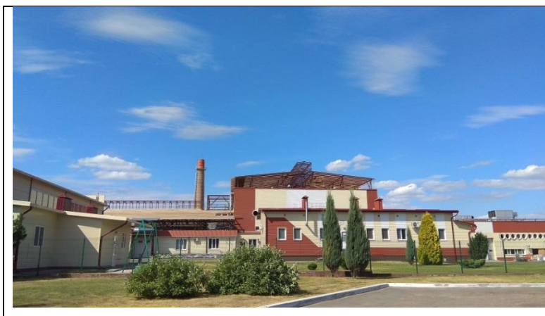
Рисунок 5. Фото цеха, на котором происходит замена кровли (вид с ул. Я. Свердлова, фото из личного архива)
