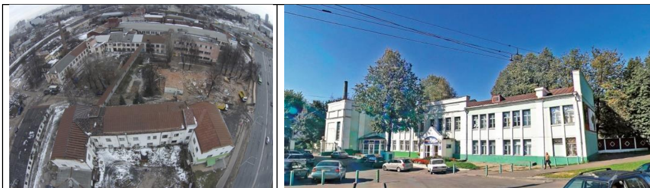
Рисунок 7. Снесённые административные здания: а – ул. К. Цеткин 5 [9]; б – ул. К. Цеткин 7 [11]
