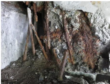
Рис. 1. Балка 29 на опоре №1.
