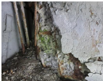
Рис. 2. Балка 30 на опоре №1.
