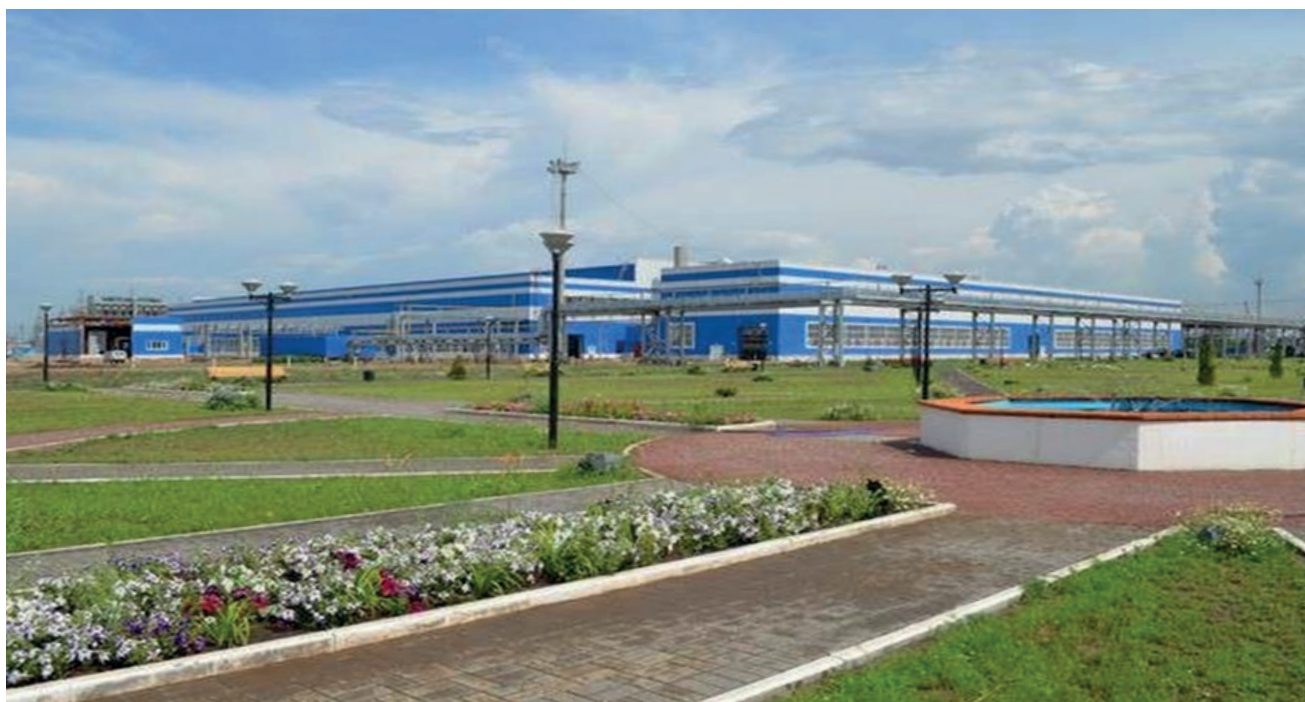
Современный производственный корпус блока литейных цехов (фотография носит иллюстративный характер)
