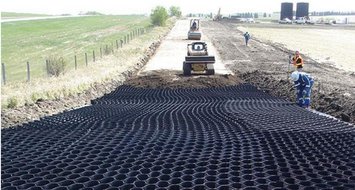
Рисунок 6 – Применение решётки Геовеб в строительстве дороги
