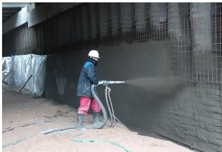
Рисунок 6 – нанесение токопроводящего бетона на стену
