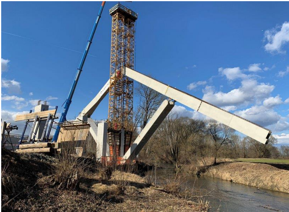
Рисунок 2 – Разворачивание балок
