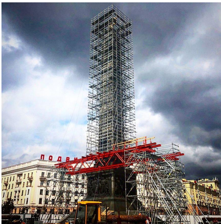
Рисунок 2 – устройство конструкции лесов для проведения работ по реставрации монумента Победы
