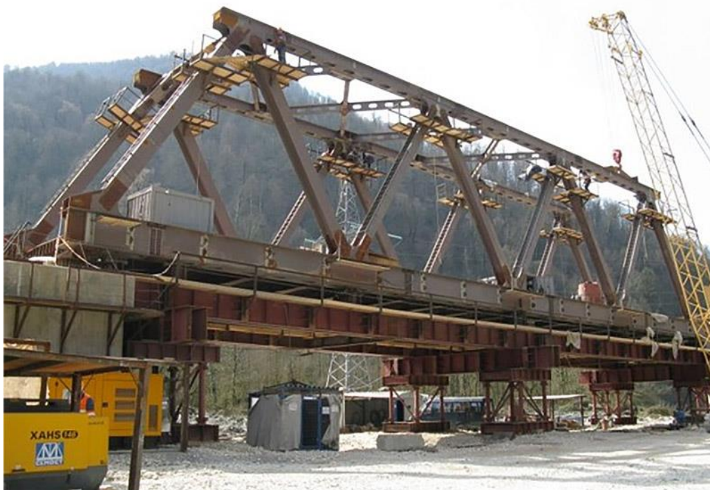
Рисунок 1 – сборка металлического пролетного строения
