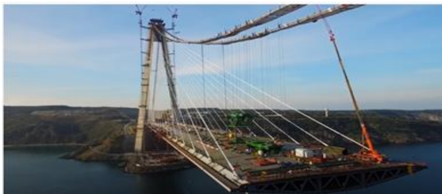
Рисунок 1 – Мост через пролив Босфор
