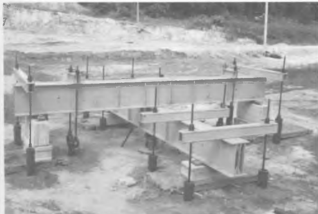
Рис. 3. Загрузочный стенд для испытания свай при вдавливающих нагрузках до 5000 кН
