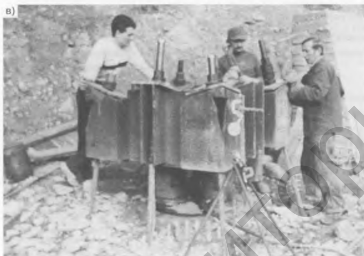
1 — тампонажная обойма в верхней части ствола; 2 — пята; 3 — упругая легкосжимаемая прокладка для разделения пяты и ствола сваи; 4 — внутренняя труба для передачи вдавливающего усилия на пята; 5, 6 — упорные пластины; 7 — наружная труба с заливкой между ней и стенками скважины для передачи сдвигающего усилия на ствол сваи при его выдавливании вверх; 8 — тяги упора; 9 — гидравлический домкрат
