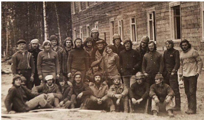
Бойцы Белорусского государственного института народного хозяйства на строительстве двухэтажного деревянного дома в г. Стрежевой Томской области, 1978 г.
