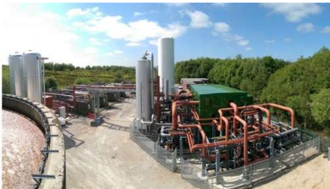
Рисунок 3 Криогенная аккумулирующая электростанция. Англия
